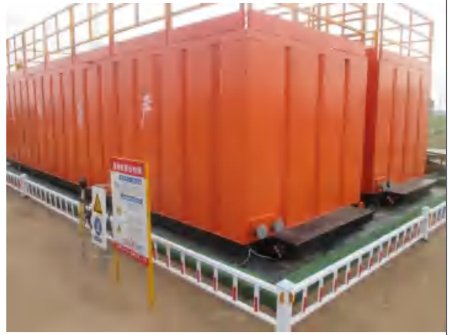
油品房、油罐区底部四周建立有效围堰，铺设防渗膜。
