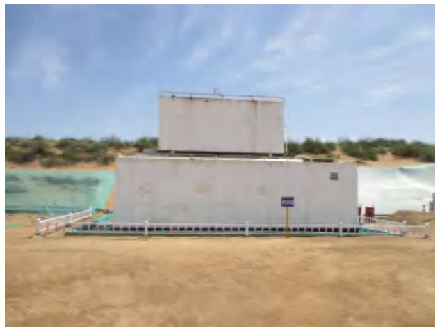
油罐区底部建立有效围堰，铺好防渗膜。
