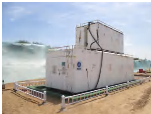
油罐区底部四周建立有效围堰，铺设防渗膜。
