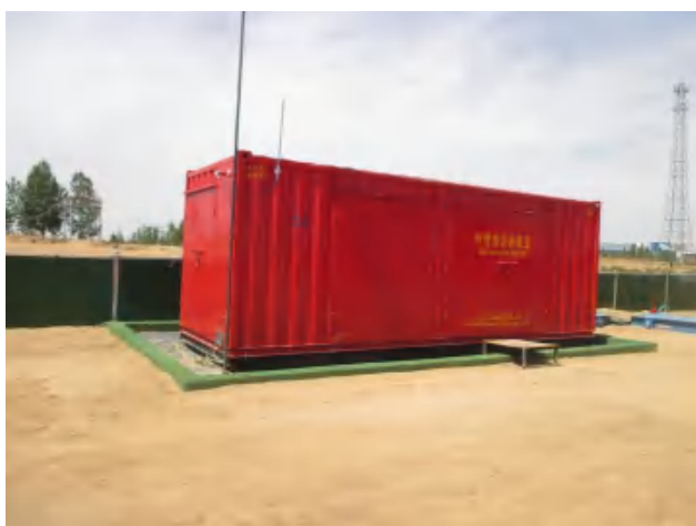
远控房区底部四周建立有效围堰，铺设防渗膜。
