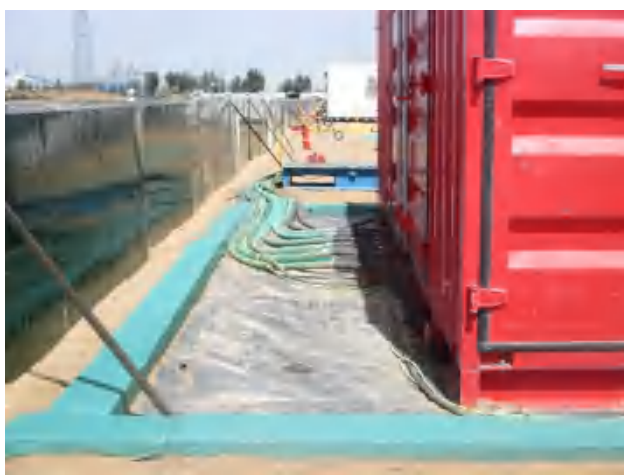
远控房区底部建立有效围堰，铺好防渗膜。
