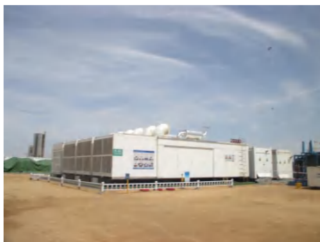
配电设备房底部四周建立有效围堰，铺设防渗膜。
