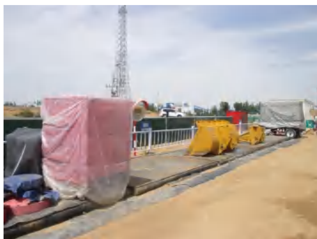
夹管器区底部四周建立有效围堰，铺设防渗膜。
