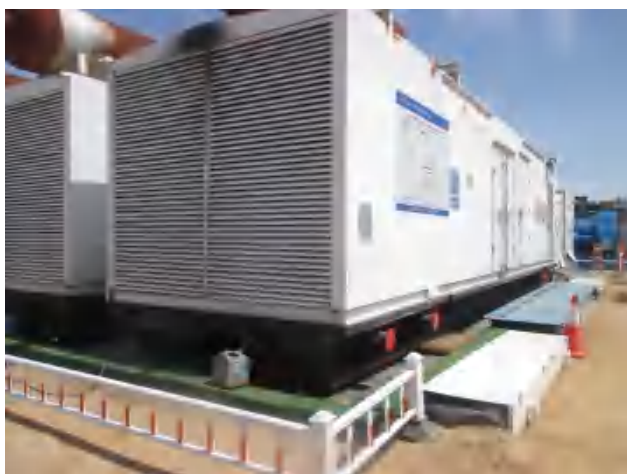
配电房区底部四周建立有效围堰，铺设防渗膜。
