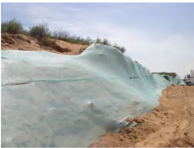
油品房、油罐区底部四周建立有效围堰，铺设防渗膜。
