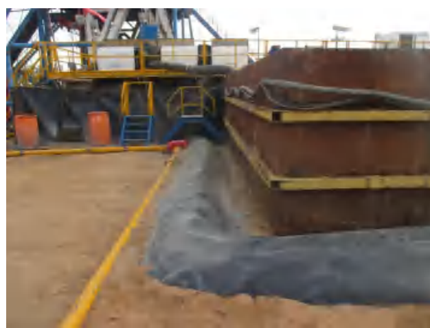
泥浆罐区底部四周建立 0.5m 高围堰，铺设 2 层 HDEP 防渗膜。
