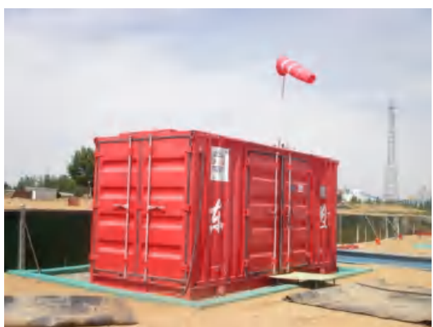
远控房区底部建立有效围堰，铺好防渗膜。
