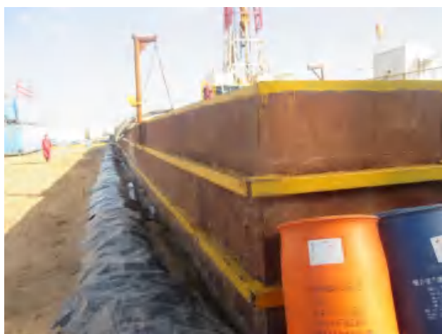
泥浆罐底部建立围堰铺好防渗膜。
