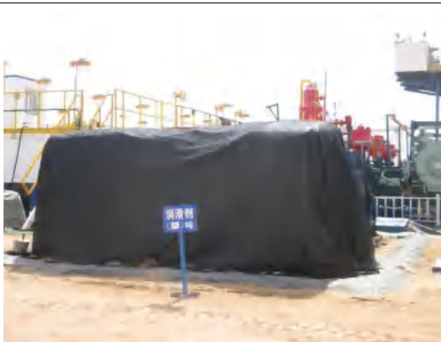
化工料区建立料台，底部铺设防渗膜，上方防扬尘及时苫盖。
