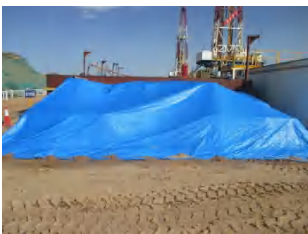
化工料区底部建立料台，铺好防渗膜，上方及时苫盖。
