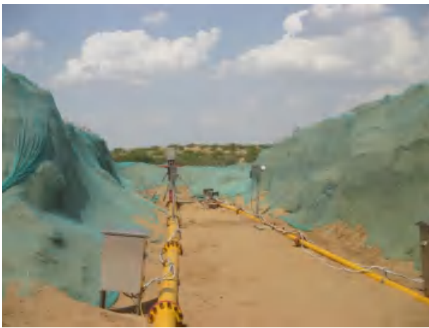
井场边坡铺设防尘网进行防风固沙，减少沙土流失和扬尘污染。
