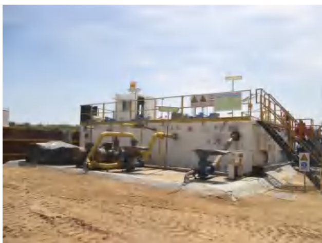
配电房区底部四周建立有效围堰，铺设防渗膜。
