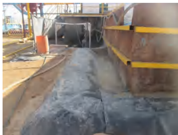
泥浆罐底部建立围堰铺好防渗膜。
