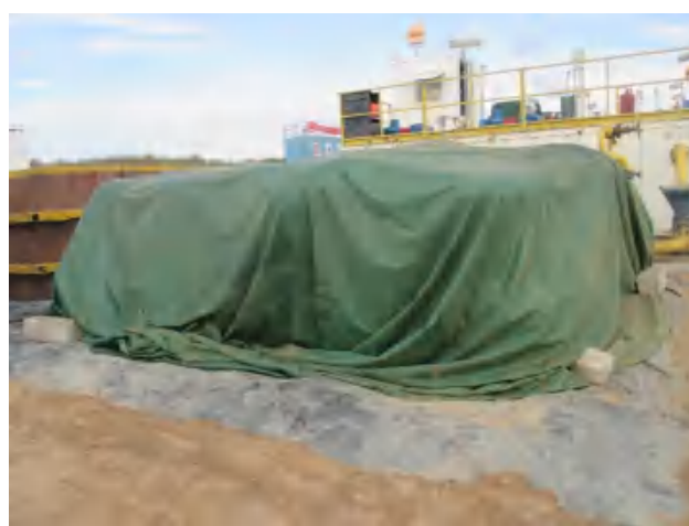
化工料区底部建立料台，底部铺设防渗膜，上方及时苫盖。
