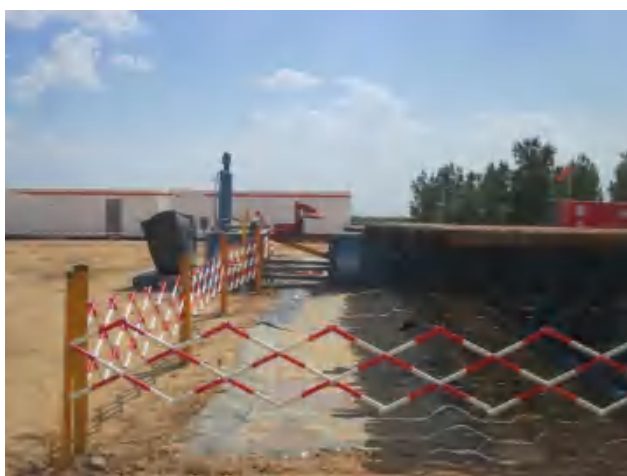
钻杆区钻杆两端底部四周建立有效围堰，铺好防渗膜。
