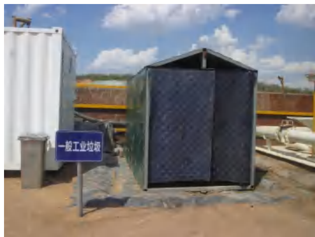
设立工业垃圾暂存间，底部建立围堰， 铺设防渗膜。
