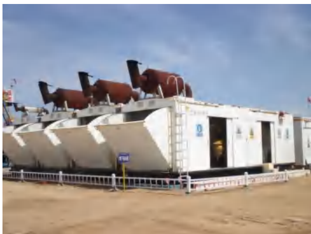
配电设备房底部建立有效围堰，铺防渗膜。
