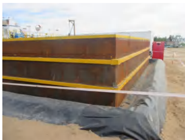
泥浆罐区四周建立 0.5m 高围堰，铺设 2 层 HDEP 防渗膜。
