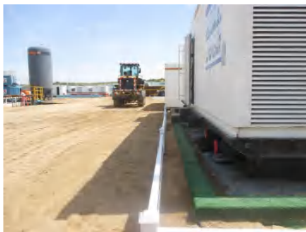
配电房区底部四周建立有效围堰，铺设防渗膜。
