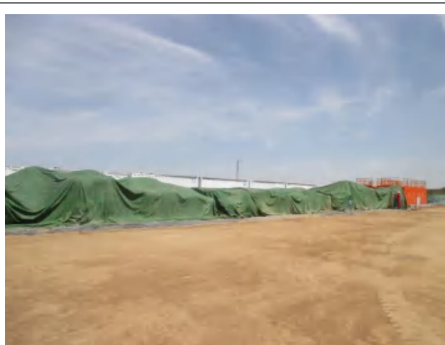
化工料区建立料台，底部铺设防渗膜，上方防扬尘及时苫盖。
