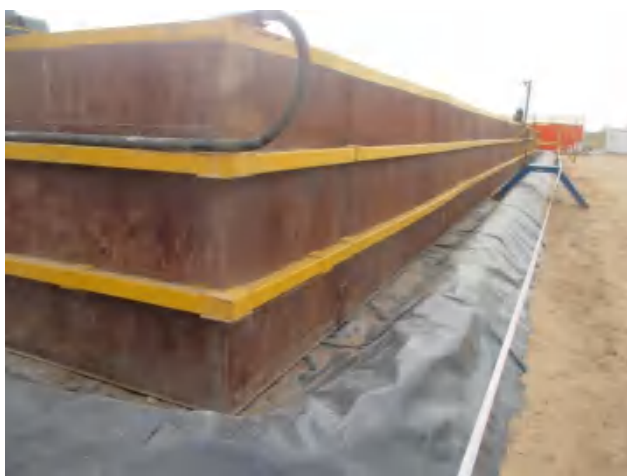
泥浆罐区四周建立 0.5m 高围堰，铺设 2 层 HDEP 防渗膜。
