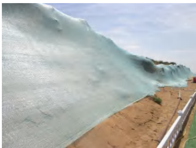
井场边坡铺设防尘网进行防风固沙，减少沙土流失和扬尘污染。
