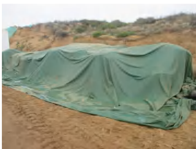
化工料区底部建立料台，底部铺设防渗膜，上方及时苫盖。
