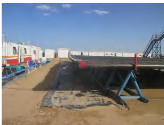
钻杆区钻杆两端底部四周建立有效围堰，铺好防渗膜。
