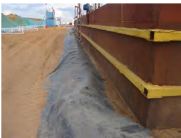
泥浆罐区底部四周建立 0.5m 高围堰，铺设 2 层 HDEP 防渗膜。
