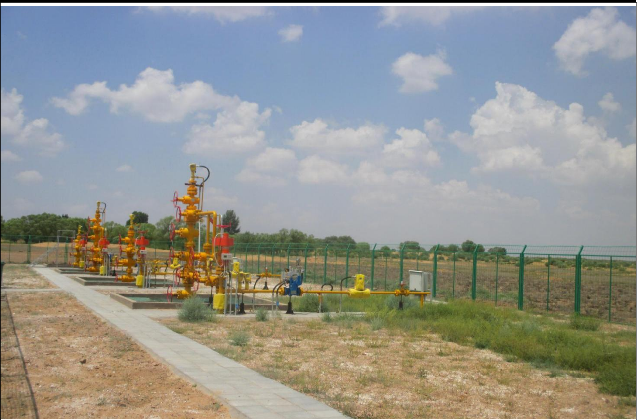
现场建设 9 口天然气井
