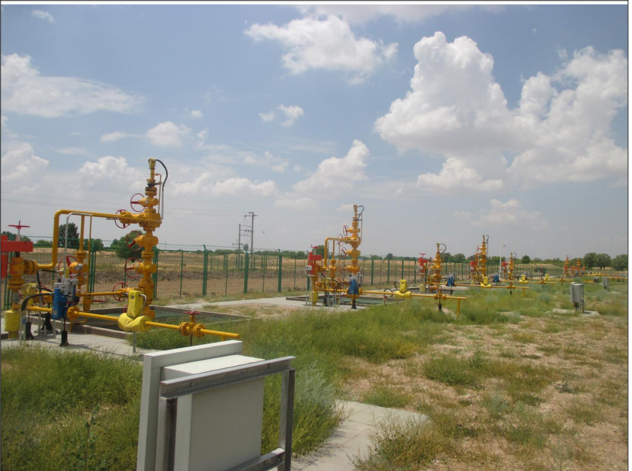
现场建设 9 口天然气井
