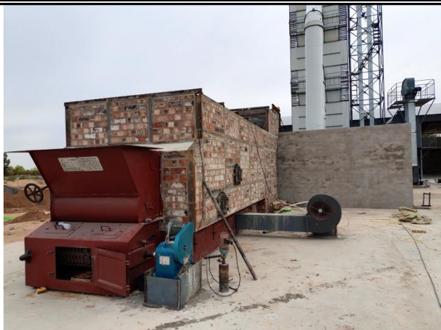
热风炉（生物质锅炉）
