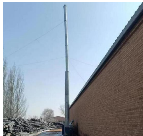
原料破碎布袋除尘器+15米高排气筒
