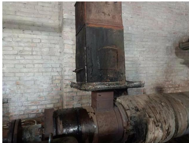
再生颗粒熔融挤出废气密封连接
