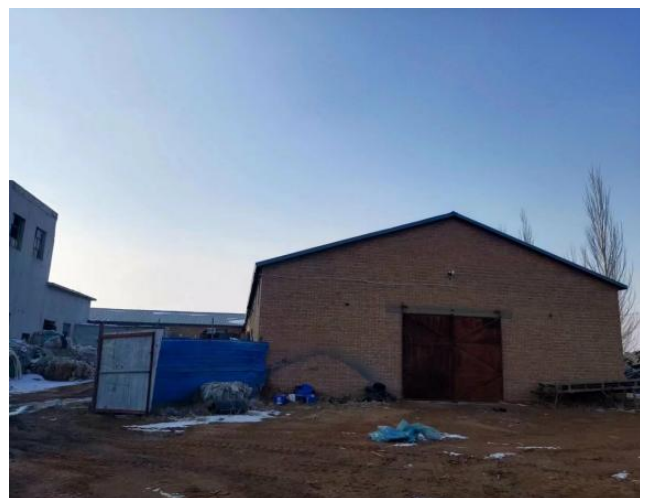
一般固废暂存间
