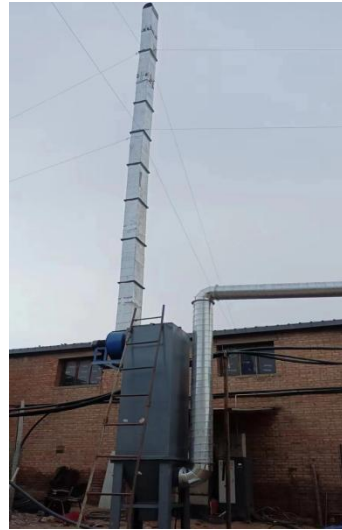
原料破碎布袋除尘器+15米高排气筒
