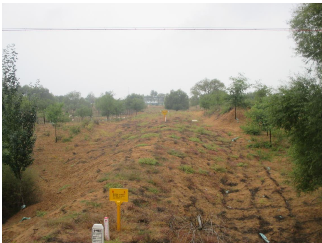
SN0113 管线植被恢复情况
