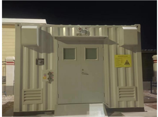
危废库房外部
