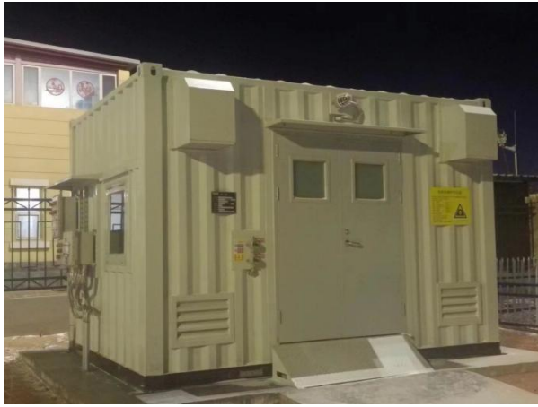
危废库房外部
