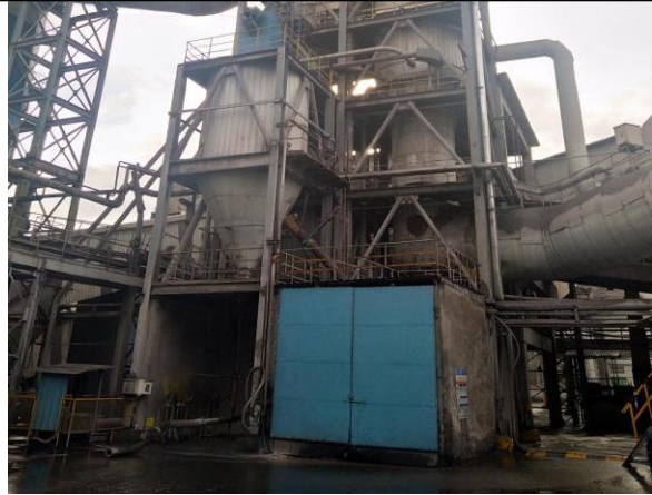
脱硫剂储仓自带配套仓顶收尘器
