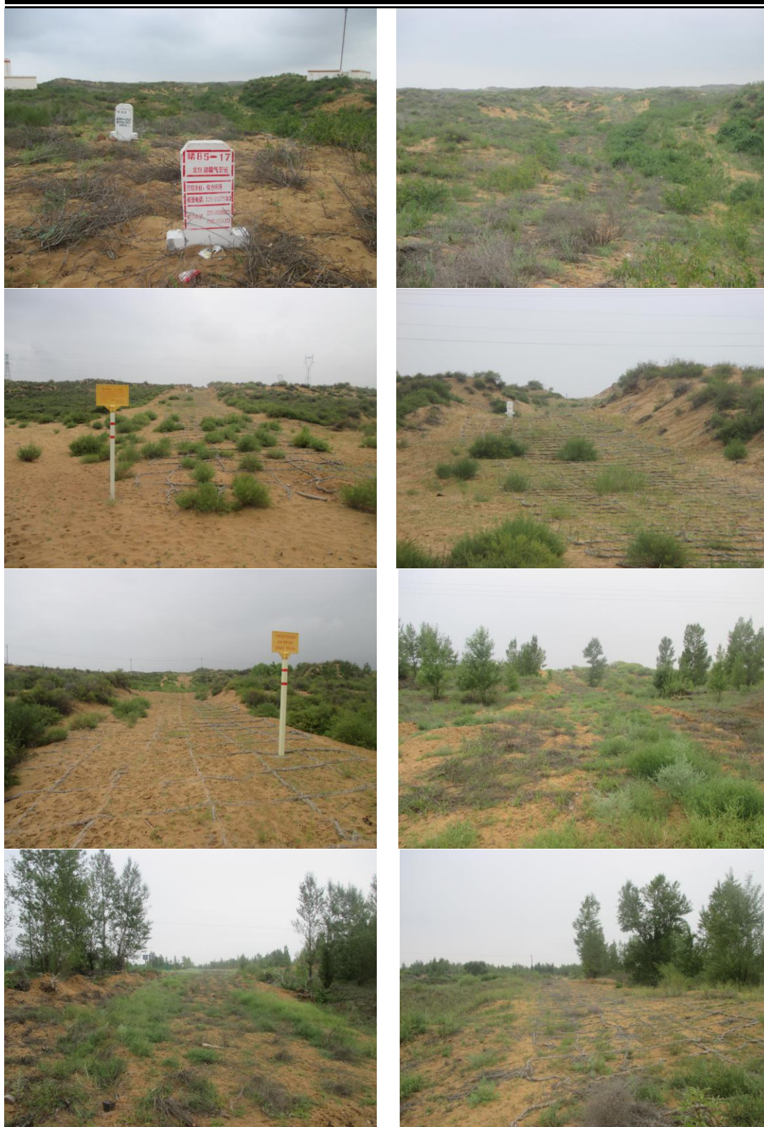
管线植被恢复情况
