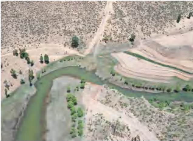
管线穿越东门沟
