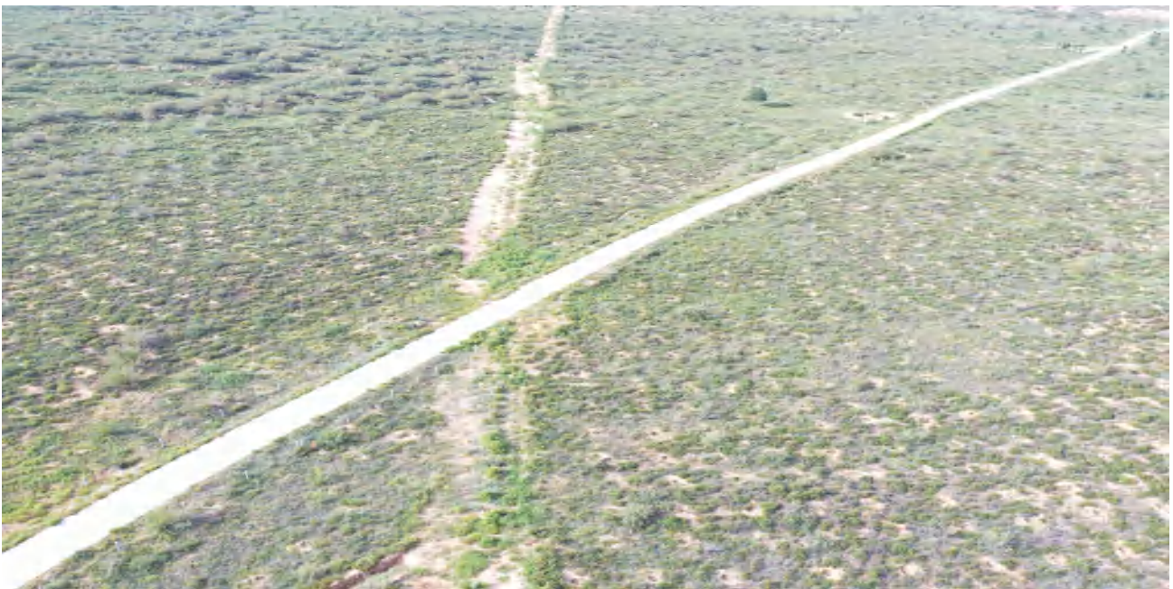
管线穿越水泥路
