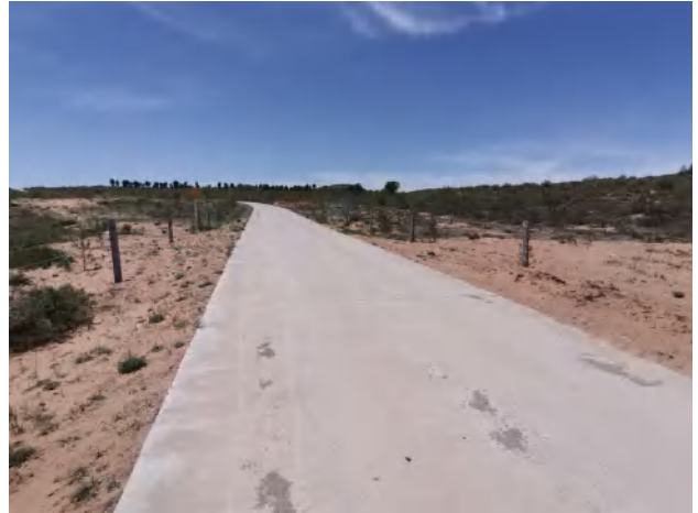
管线穿越水泥路
