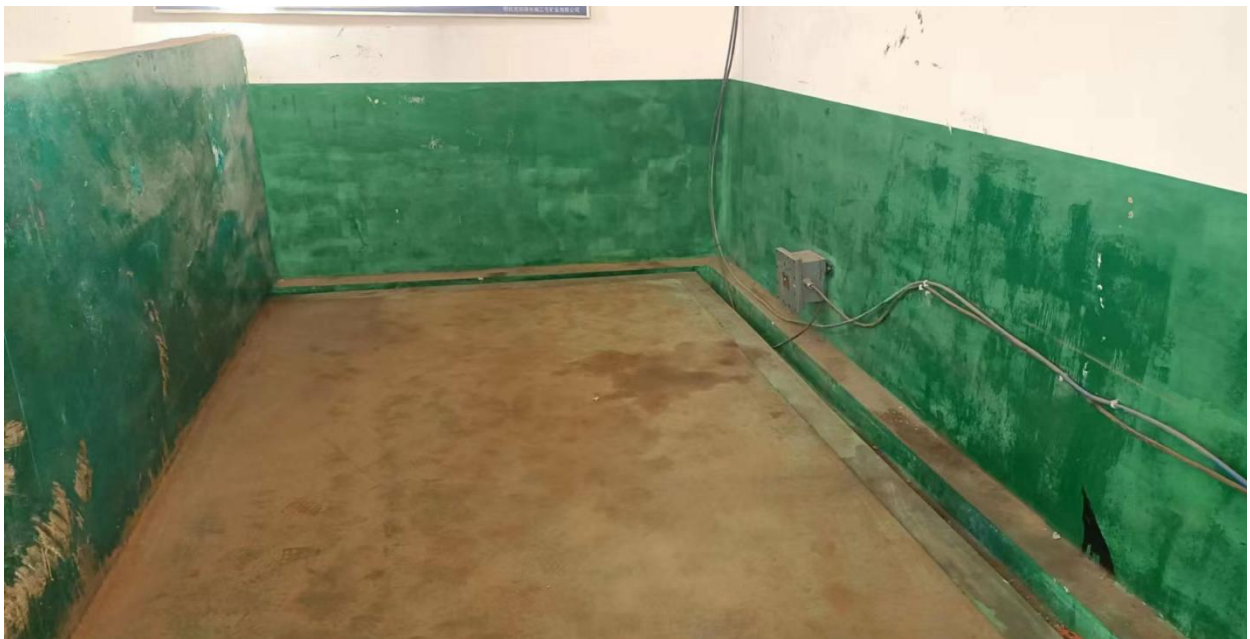
危废库房内部
