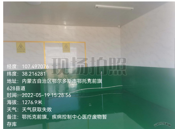
医疗废物库房内部
