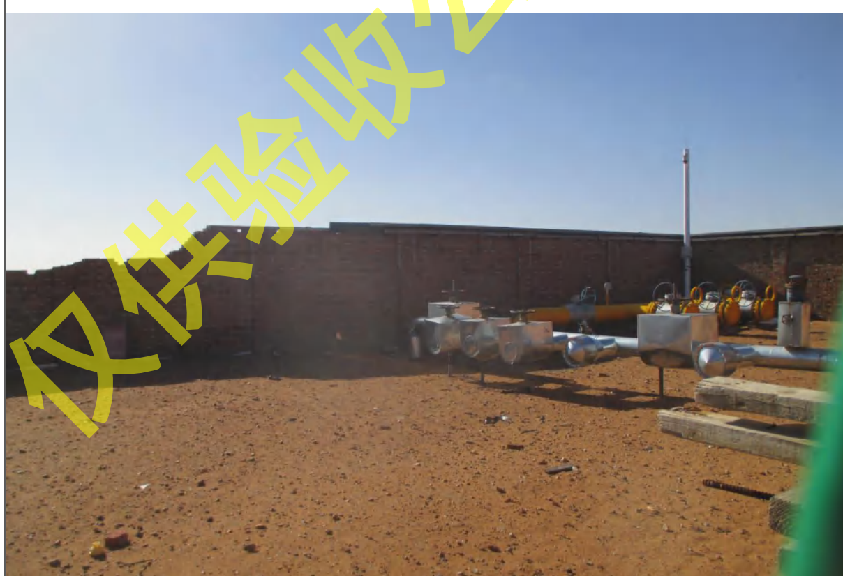
阀室内部完成防腐
