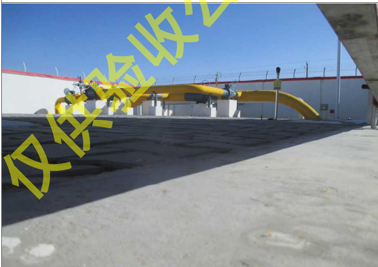
阀室内部完成硬化和防腐
