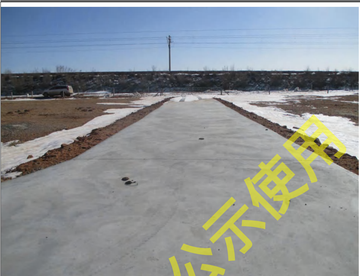
阀室进场道路
