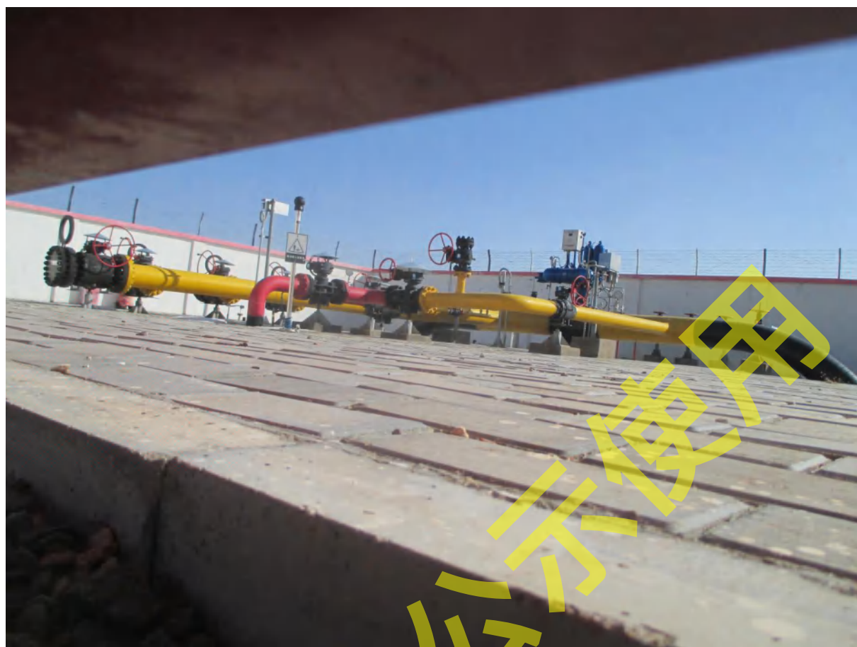
阀室内部硬化及防腐
