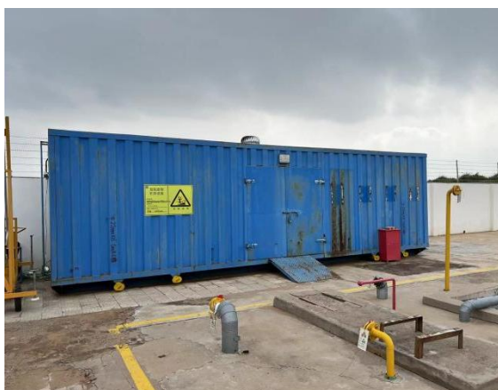
危废暂存库房外部
