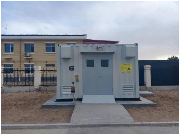
危废库房外部
