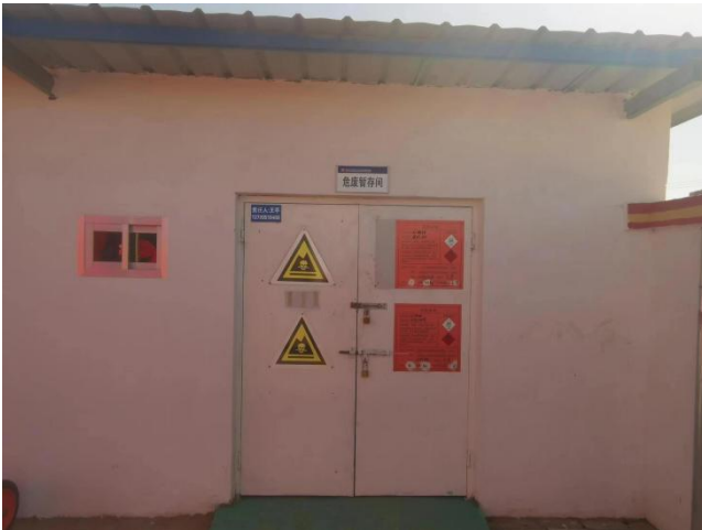
危废库房外部
