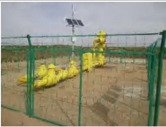
井场植被恢复照片
