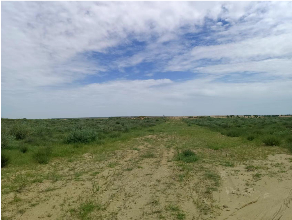
管线作业带恢复
