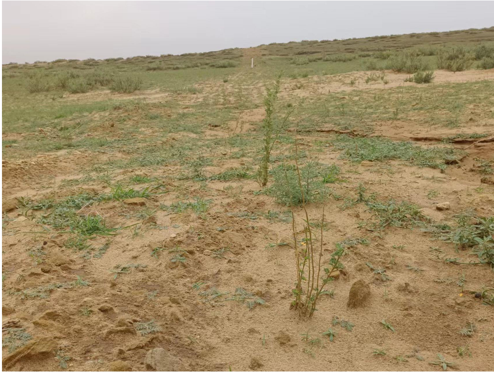
管线作业带恢复
