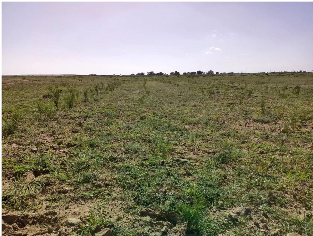
管线作业带恢复
