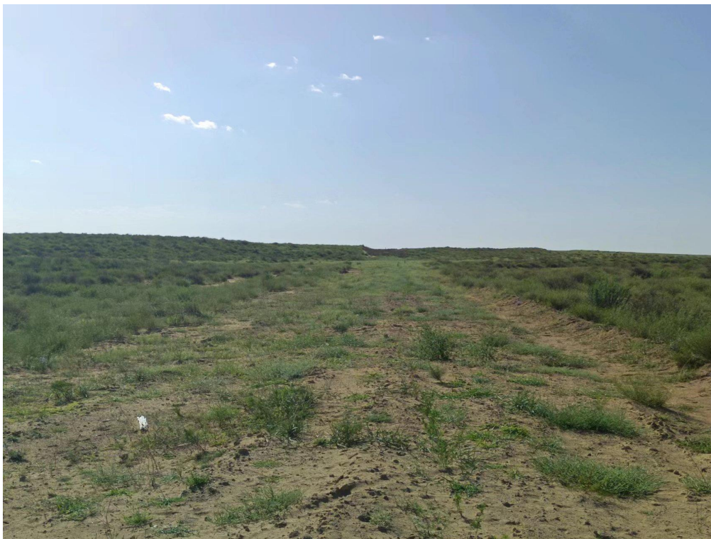
管线作业带恢复
