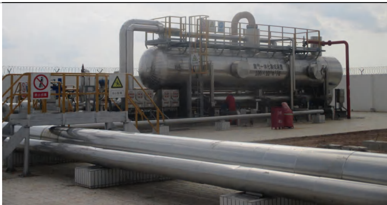
图 5 一体化集气集成装置结构图
