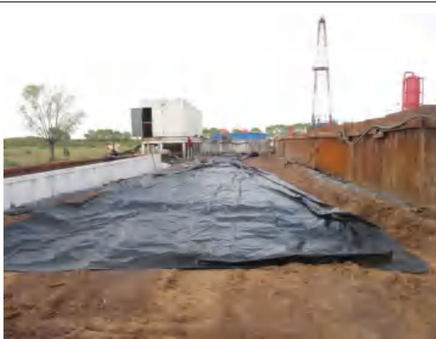
泥浆罐区底部铺设 2 层 HDEP 防渗膜（岩屑装车区域临时铺设防渗膜）。
