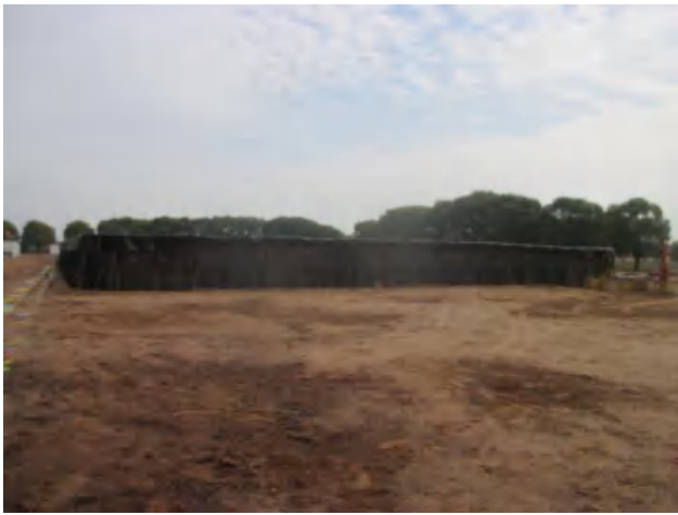
压裂液暂存池内部铺设 2 层防渗膜。
