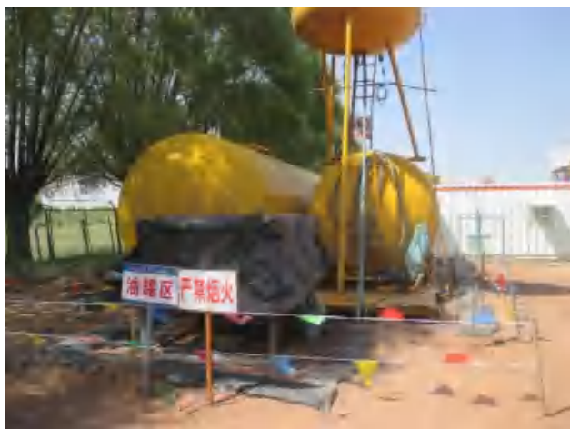
油罐区底部铺设 2 层 HDEP 防渗膜。
