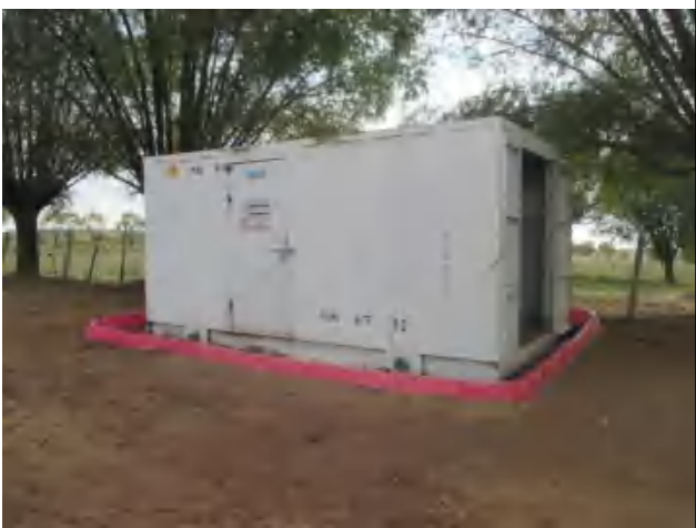
电机房底部建立围堰，做好防渗。
