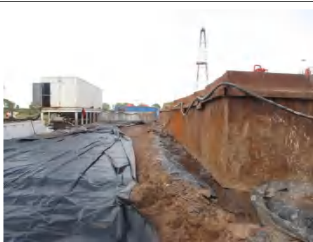
泥浆罐区底部铺设 2 层 HDEP 防渗膜（岩屑装车区域临时铺设防渗膜）。
