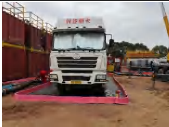
设备作业底部铺设防渗膜，四周建立有效围堰。
