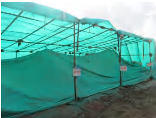
化工料区建立料棚料台，下铺上盖建立有效防渗。
