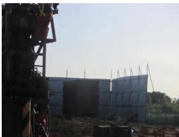
放喷区四周建立防火墙围挡，放喷罐底部有积液池，底部做好防渗。
