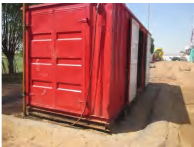
远控房区底部铺设防渗膜，四周建立有效围堰。
