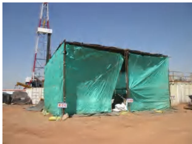
建立化工料棚，‘下铺上盖’。
