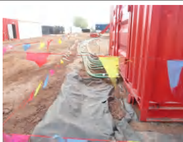
远控房区四周建立有效围堰铺好防渗膜。
