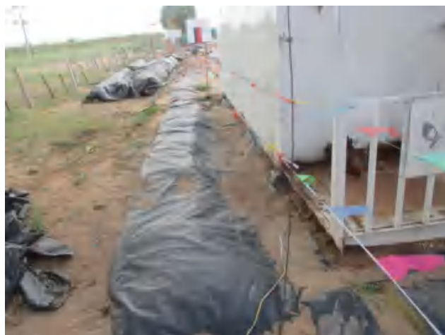
井场其他设备底部建立有效围堰铺设防渗膜。
