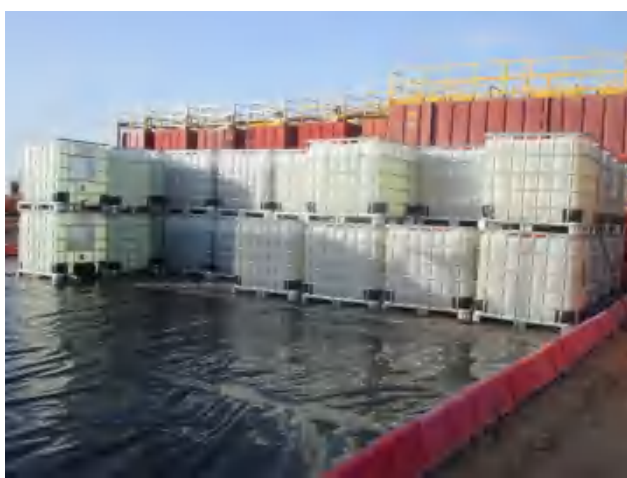
化工料底部铺设防渗膜，四周建立有效围堰。
