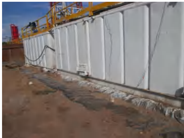
循环罐区建立有效防渗。
