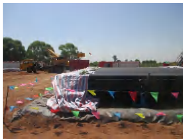
钻杆区四周建立有效围堰铺好防渗膜，钻杆两端进行包裹。
