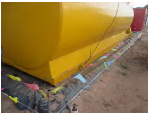
油罐区底部铺设 2 层 HDEP 防渗膜。
