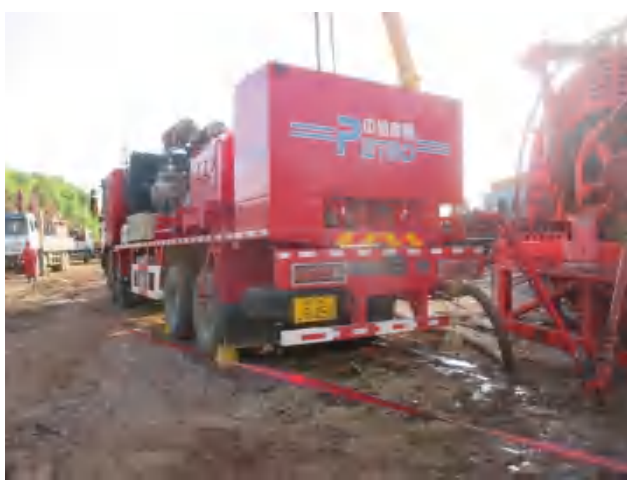
临时移动设备作业底部铺设防渗膜。
