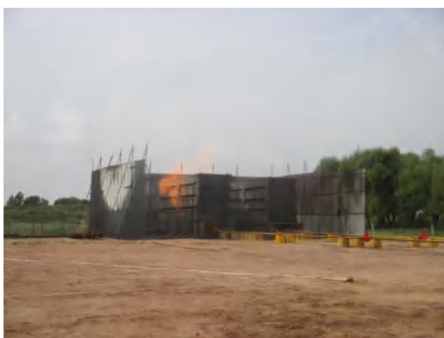
放喷区四周建立防火墙围挡，放喷罐底部有积液池，底部做好防渗。
