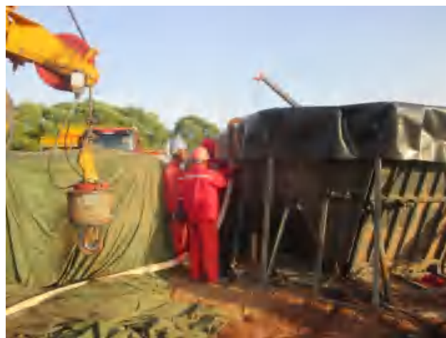
清水、压裂液暂存池内部铺设2层HDEP防渗膜，连接处采用热焊接。
