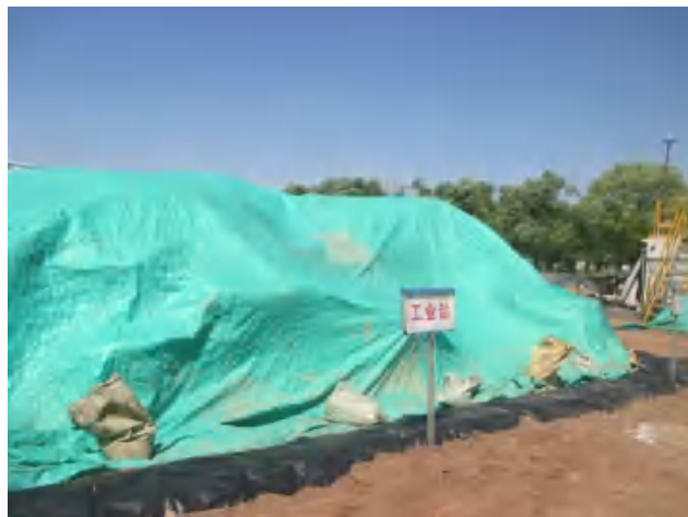
化工料区建立料棚料台，下铺上盖建立有效防渗。
