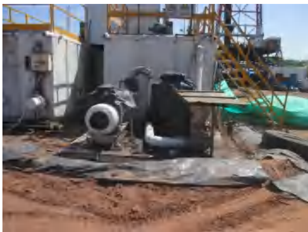
化工配料口建立有效防渗。
