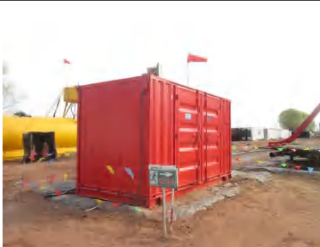
远控房区四周建立有效围堰铺好防渗膜。
