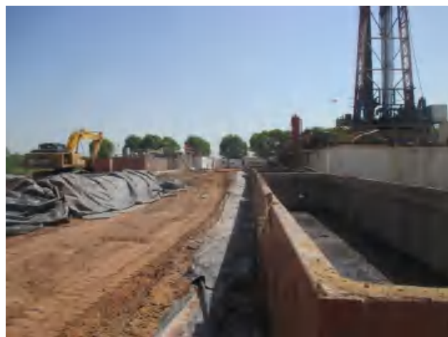
泥浆罐区底部建立高围堰，铺设防渗膜。
