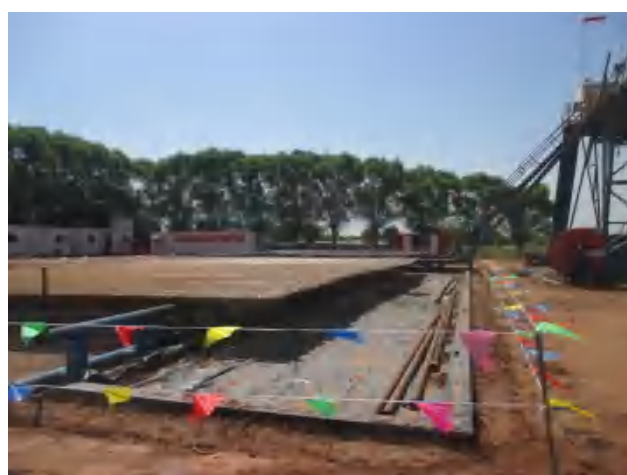
钻杆区钻杆两端底部四周建立有效围堰，铺设防渗膜。
