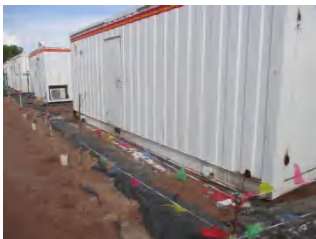
井场其他设备底部建立有效围堰铺设防渗膜。
