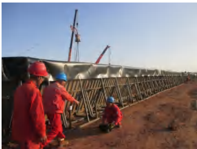
清水、压裂液暂存池内部铺设2层HDEP防渗膜，连接处采用热焊接。
