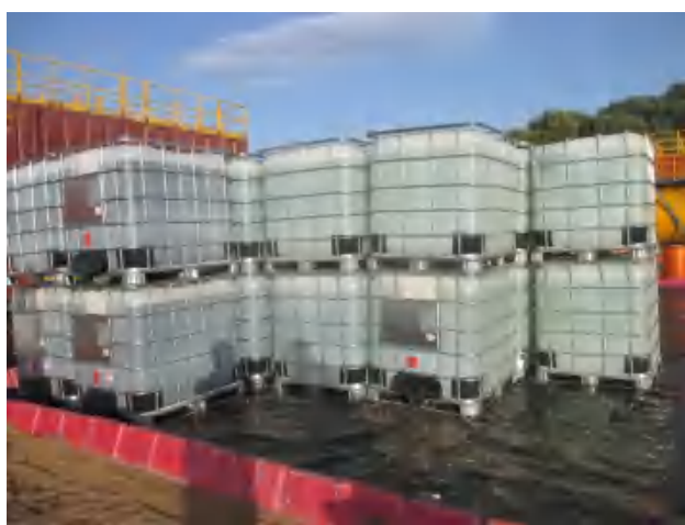
化工料底部铺设防渗膜，四周建立有效围堰。
