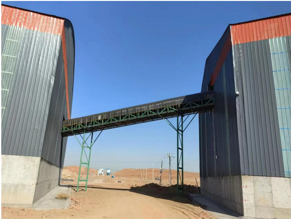
全封闭输煤栈道
