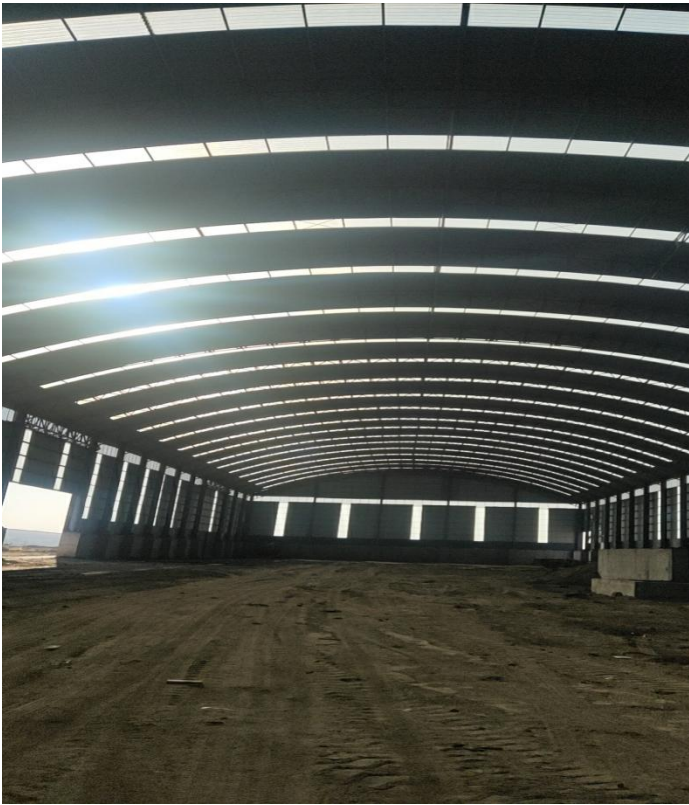
全封闭储煤棚
