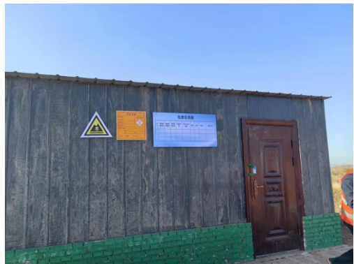
全封闭危废库
