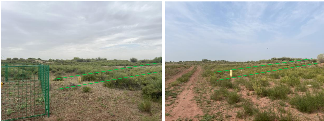
管线作业带恢复
