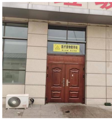
医疗废物暂存间外部
