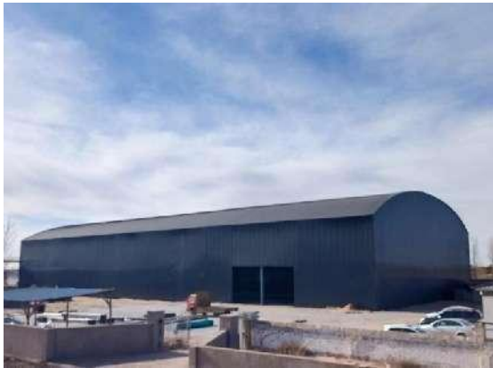
全封闭厂房外部
