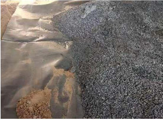
原料库底部铺设防渗膜
