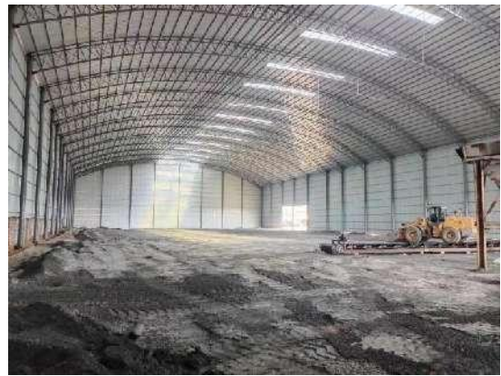
全封闭厂房内部
