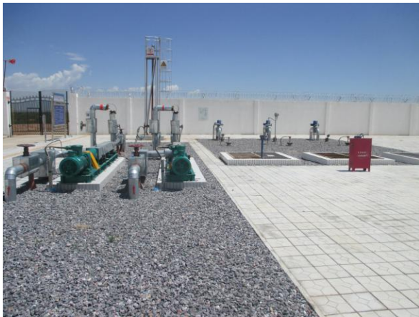
采出水外输泵区及采出水储罐区
