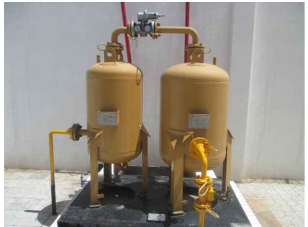
冷凝水回收装置
