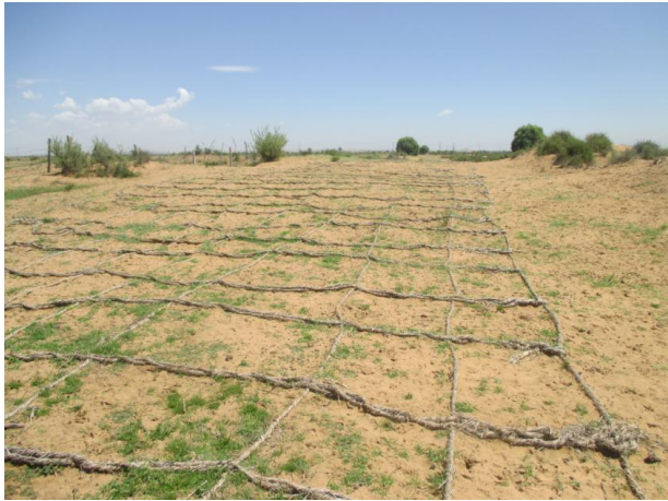
管线植被恢复情况
