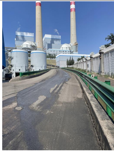
厂区地面硬化
