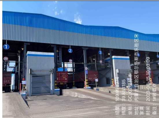
重地磅房/受煤坑
