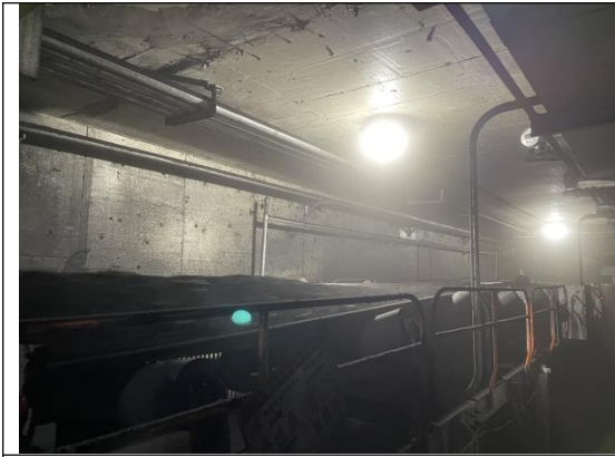
转载点地下输煤通道
