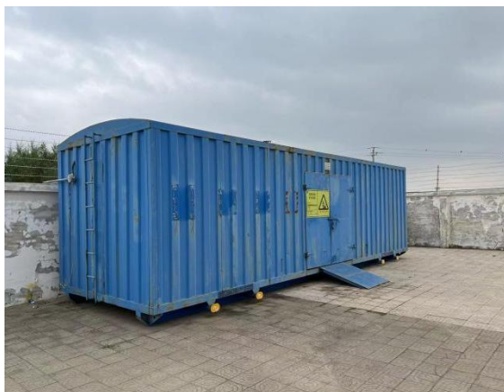
危废暂存库房外部
