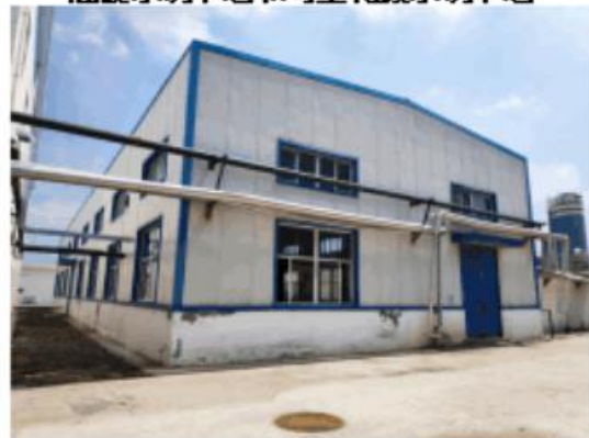
综合处理车间
