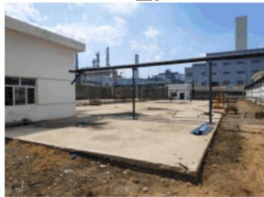
高硬水调节池和可生化废水调节池
