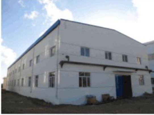
全封闭净水车间
