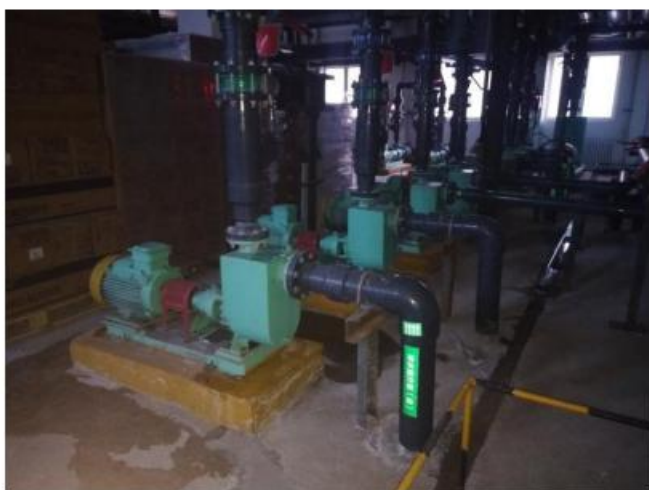
泵类安装独立减振基础
