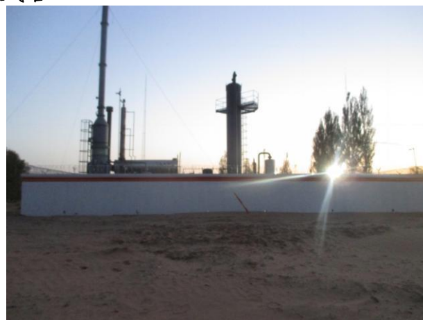
100×10 4 /d 处理规模三甘醇脱水撬及尾气焚烧一体化装置
