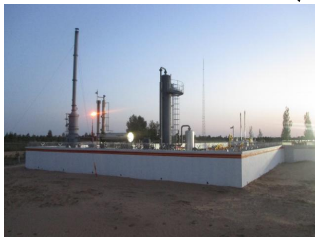
100×10 4 /d 处理规模三甘醇脱水撬及尾气焚烧一体化装置
