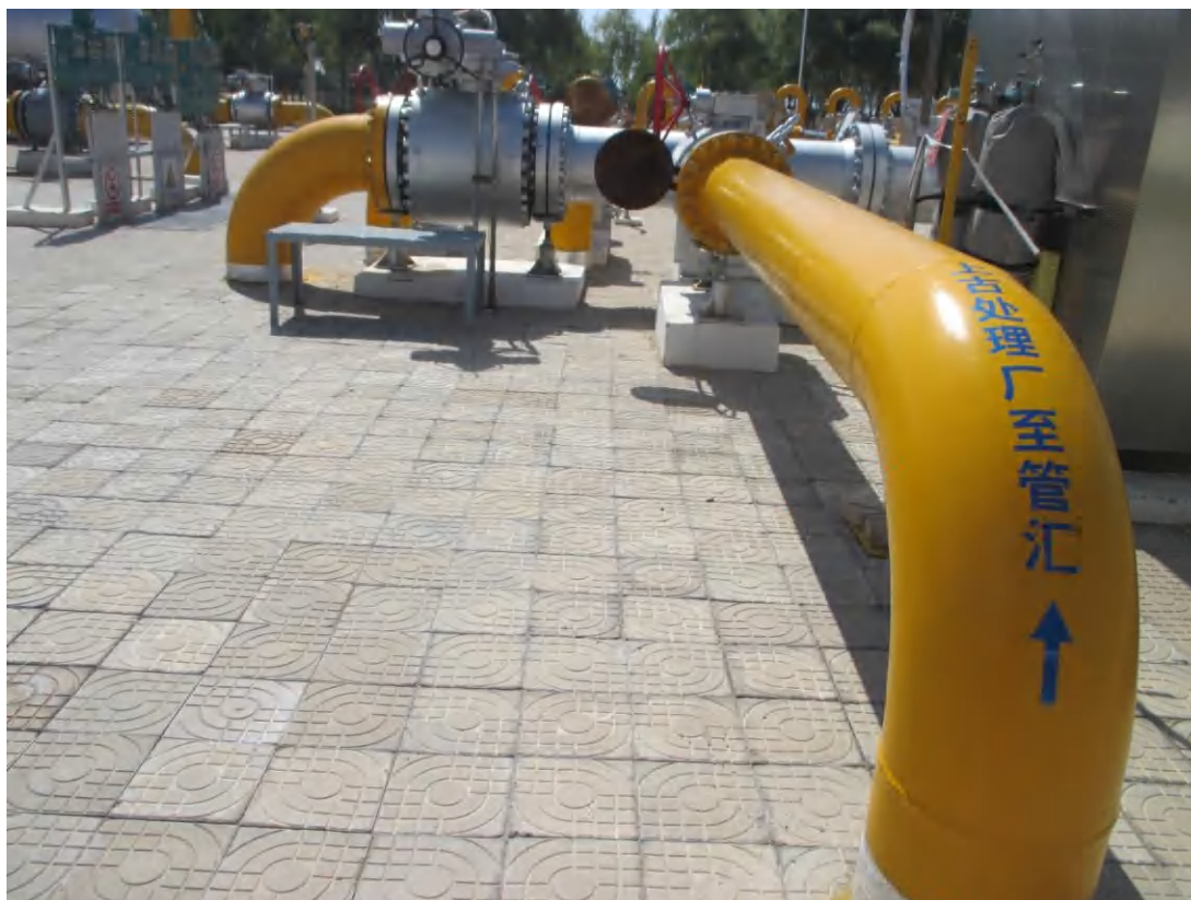
接入新建DN900配气区汇管外输
