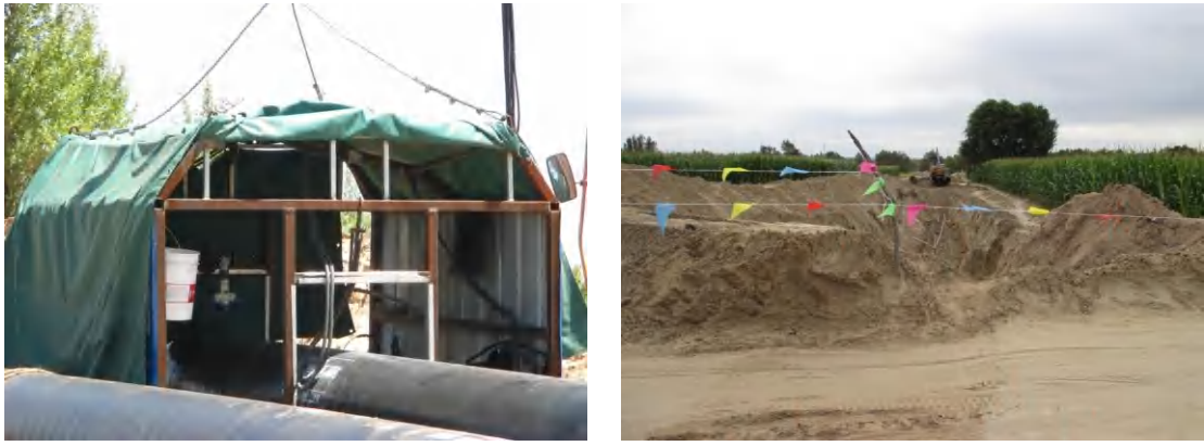
管线施工采用低噪声设备
