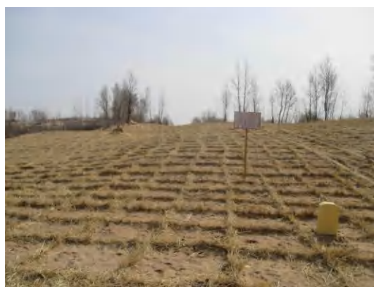
北干线伴行路两侧管线进行草方格固沙、播撒草籽
