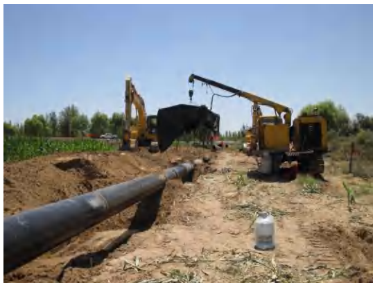
管线施工不设置施工营地
