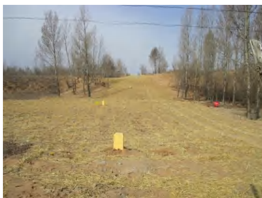
北干线伴行路两侧管线进行草方格固沙、播撒草籽
