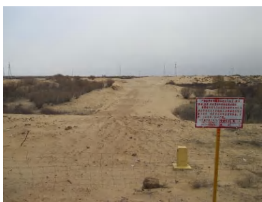
管线施工不设置弃土场、土壤全部用于管线沿线坑洼处平整使用
