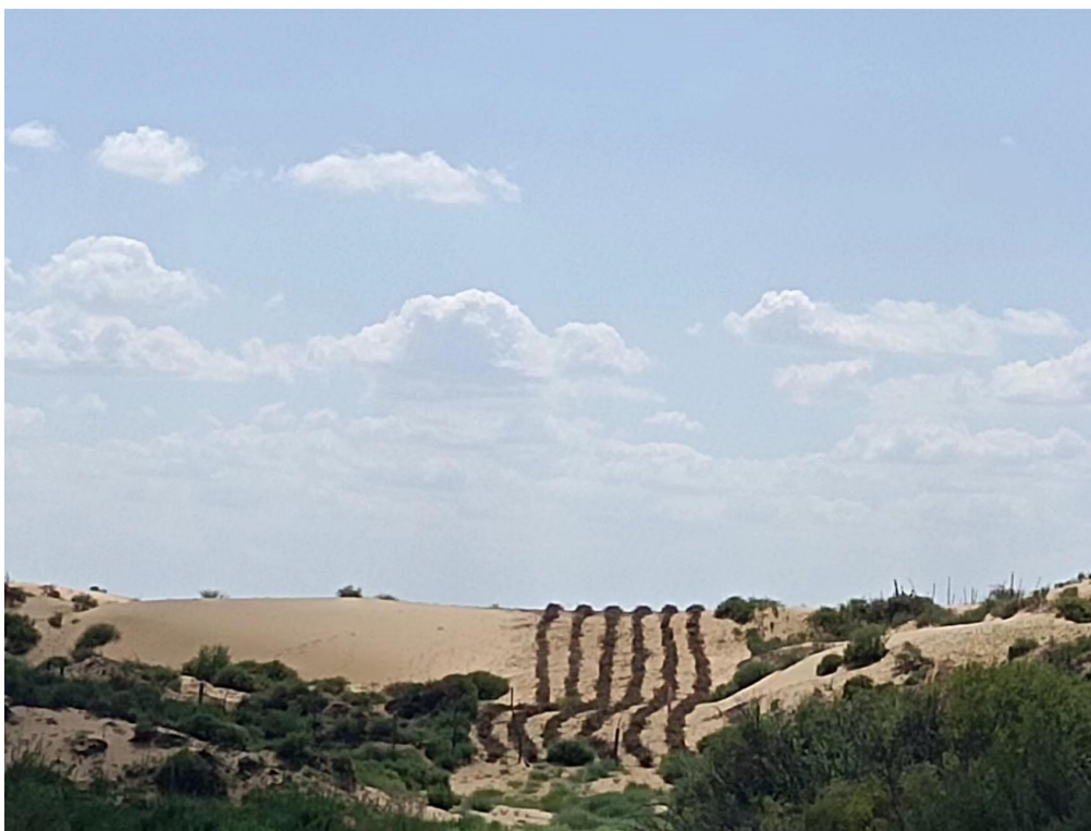
管线作业带恢复
