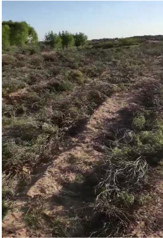
管线作业带恢复
