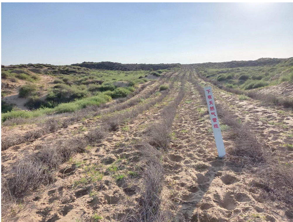
管线作业带恢复
