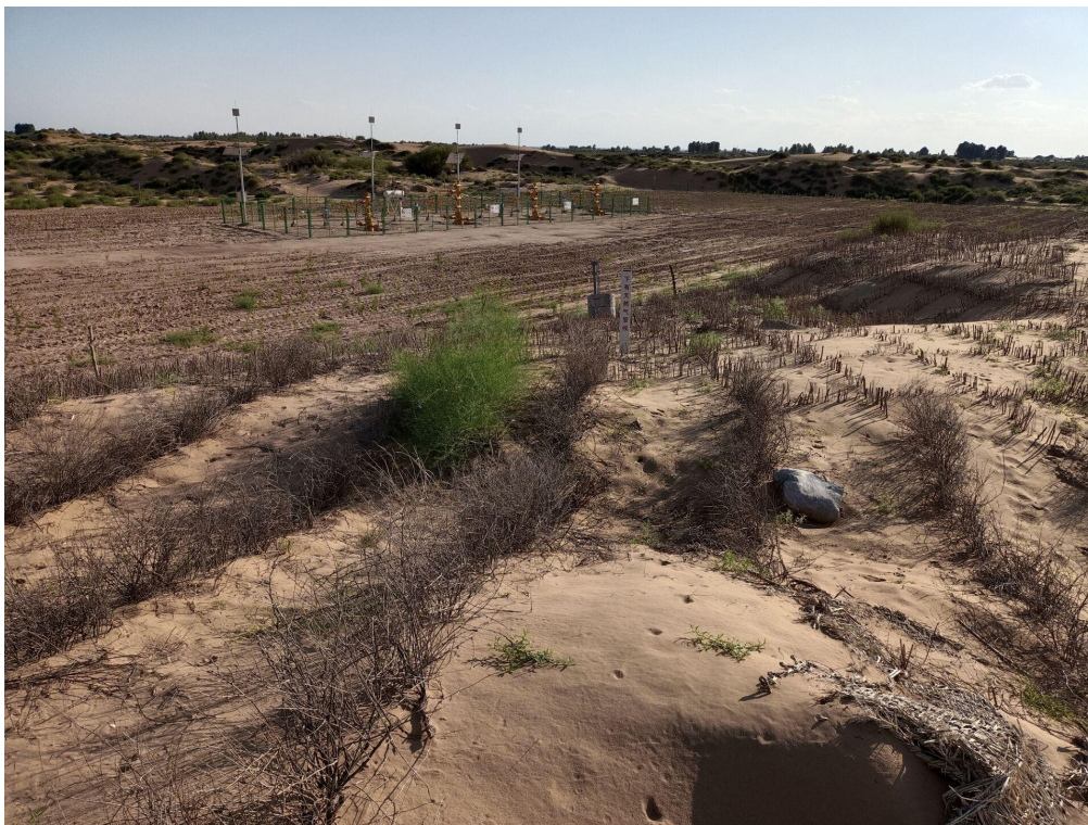
管线作业带恢复
