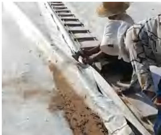
复合土工膜采用双轨焊机焊接
