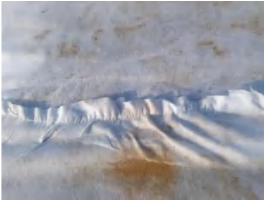
复合土工膜上方土工布缝合
