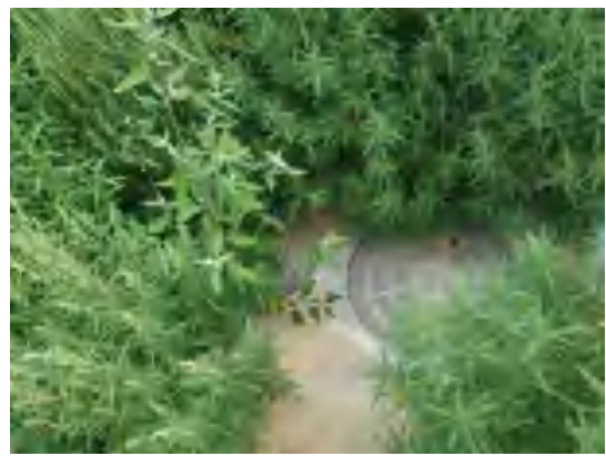
生活污水处理依托民房原有设施
