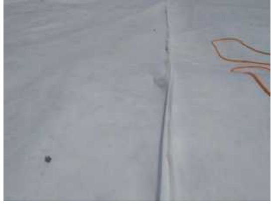
土工布采用缝包机缝合
