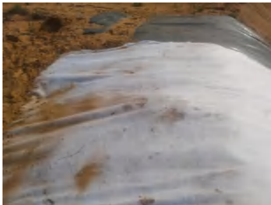
1.5mm 厚土工膜上方铺设复合土工膜
