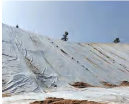
边坡土工布上方使用沙袋固定
