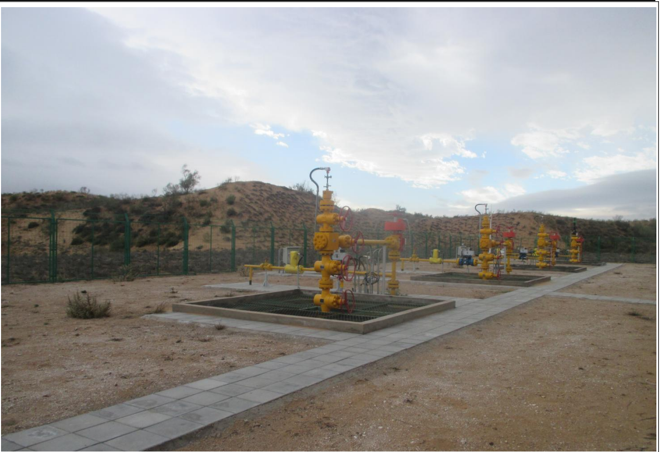
SN0169 井丛建设 9 口天然气井
