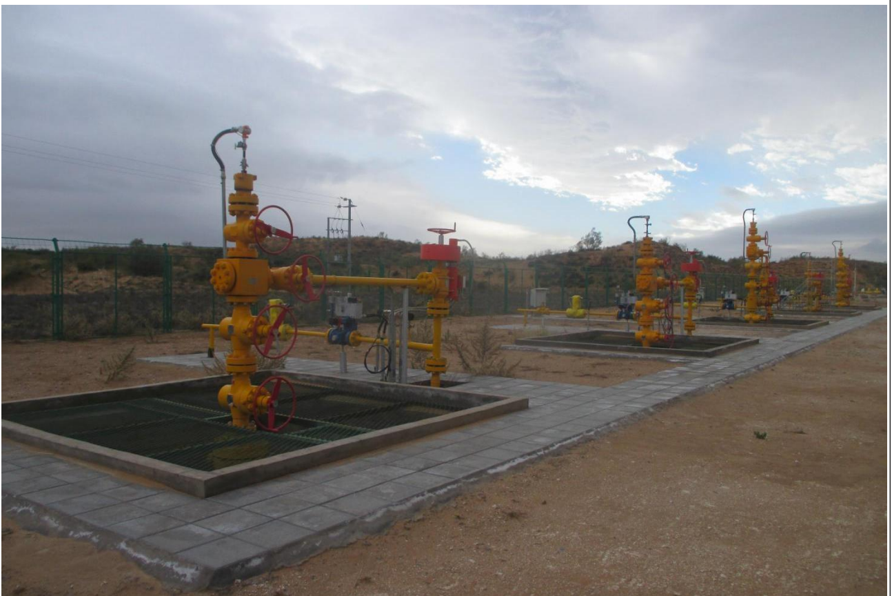
SN0169 井丛建设 9 口天然气井
