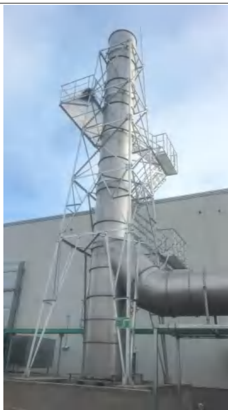
焊接废气处理设施及排气筒
