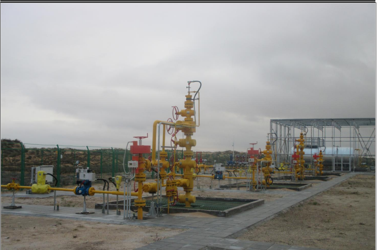
SN0122 井丛建设 9 口天然气井
