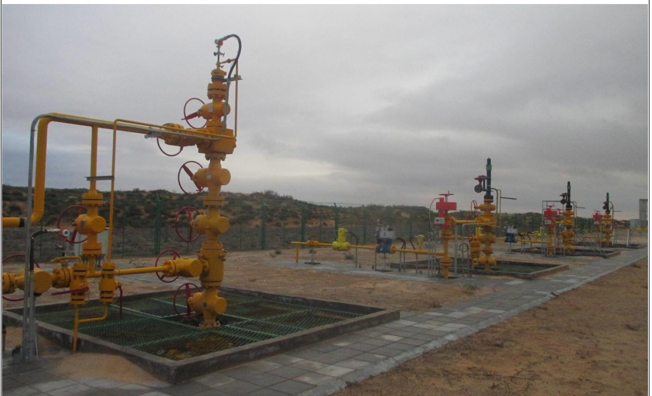
SN0122 井丛建设 9 口天然气井
