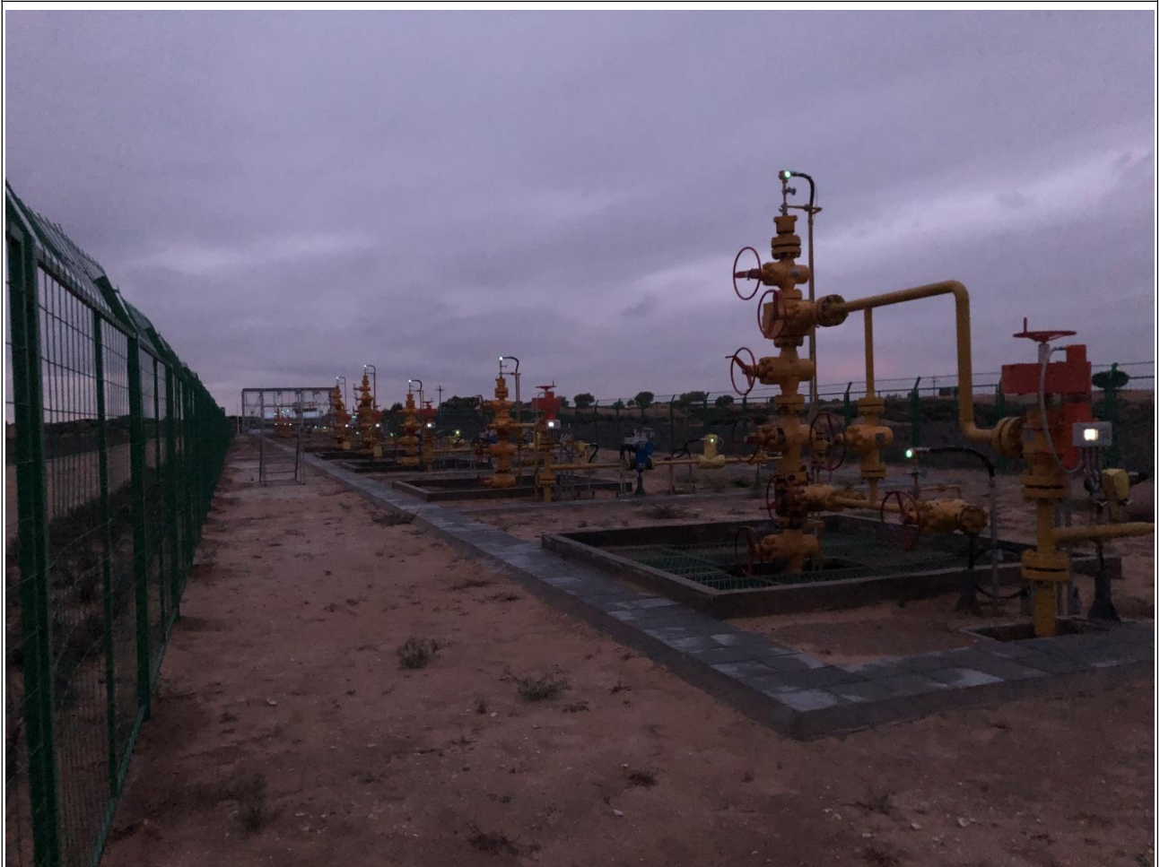
SN0095 井丛建设 9 口天然气井
