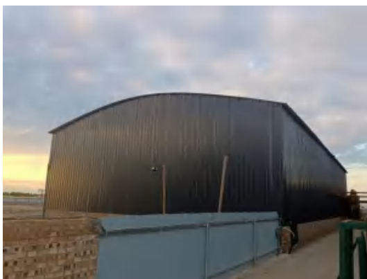
全封闭废油处理车间
