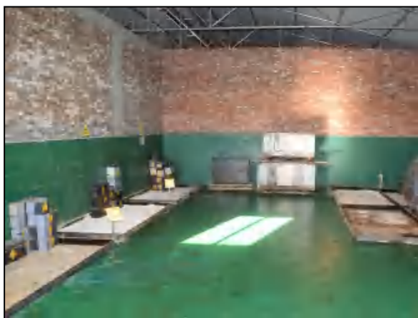
4#危废库内部（废铅蓄电池存储区域）
