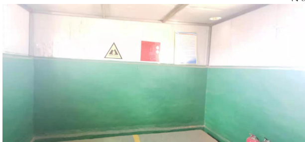
危废暂存库防腐涂漆
