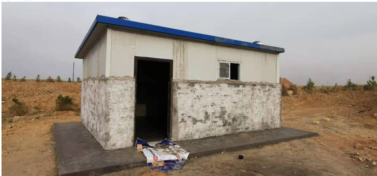
危废暂存库区
