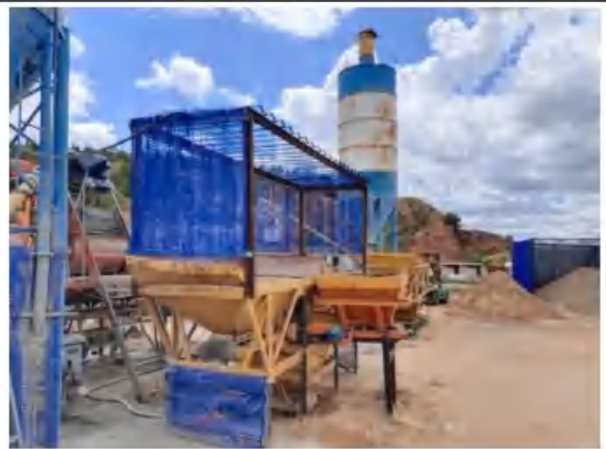
半封闭上料口
